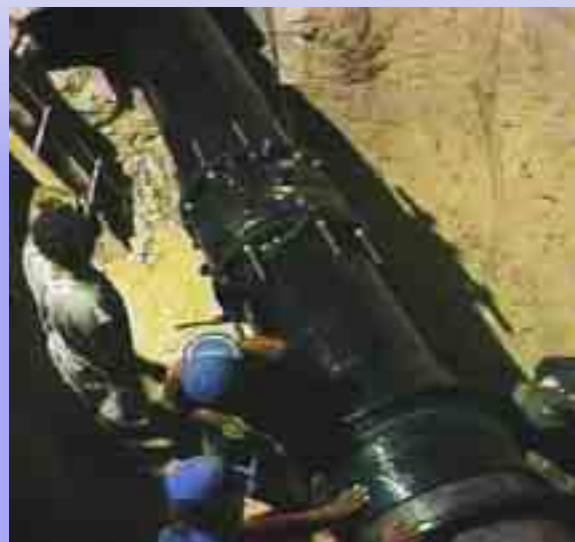
INSTALAÇÃO DO MEDIDOR MAGNÉTICO DE VAZÃO
